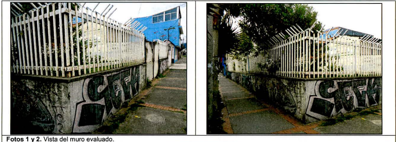
Fotos 1 y 2. Vista del muro evaluado.
