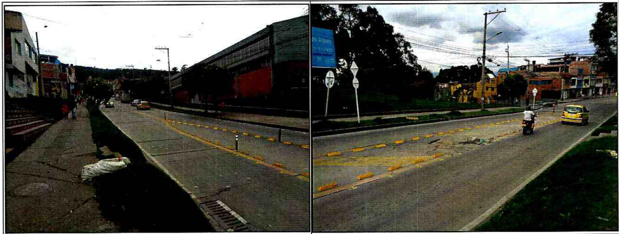
Fotos 5 y 6. Vista del tramo vial evaluado.
