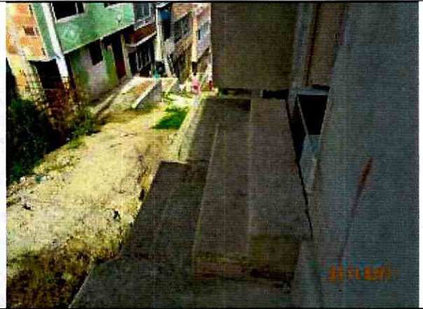
Fotografía 8. Andenes de la vivienda de la Diagonal 100B Sur 6-42 Este, en el Barrio Nuevo Porvenir de la Localidad de Usme.
