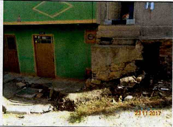
Fotografía 4. Andenes de la vivienda de la Diagonal 100B Sur 6-42 Este, en el Barrio Nuevo Porvenir de la Localidad de Usme.
