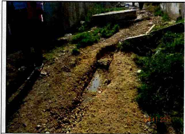
Fotografía 13. Redes hidráulicas en la Diagonal 100B Sur, en el Barrio Nuevo Porvenir de la Localidad de Usme.
