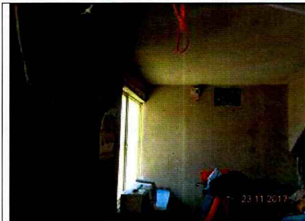
Fotografía 9. Interior del primer nivel de la Diagonal 100B Sur 6-42 Este, en el Barrio Nuevo Porvenir de la Localidad de Usme.
