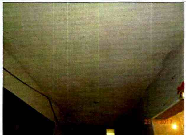
Fotografía 10. Interior del primer nivel de la Diagonal 100B Sur 6-42 Este, en el Barrio Nuevo Porvenir de la Localidad de Usme.
