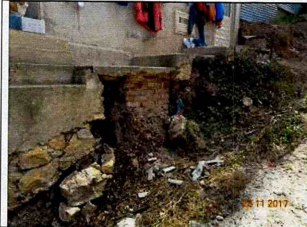
Fotografía 3. Andenes de la vivienda de la Diagonal 100B Sur 6-42 Este, en el Barrio Nuevo Porvenir de la Localidad de Usme.
