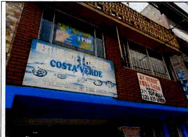
Fotografía 1. Vista de la fachada del predio Calle 49 D Bis Sur No. 5U-25, en el Sector Catastral Molinos del Surde la Localidad de Rafael Uribe Uribe
