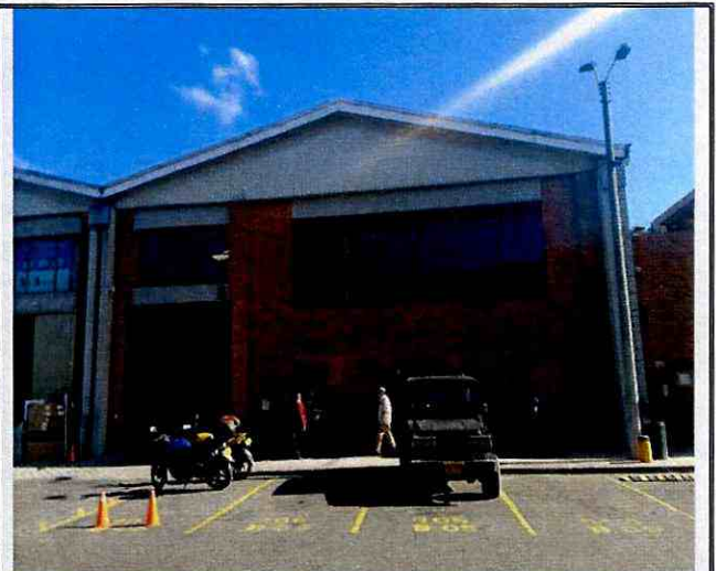
Fotografía 2. Bodega donde funciona la empresa WESCO S.A., en el Parque Empresarial Normandía P.H., ubicado en el predio de la Avenida Calle 63 No. 74 B – 42.
