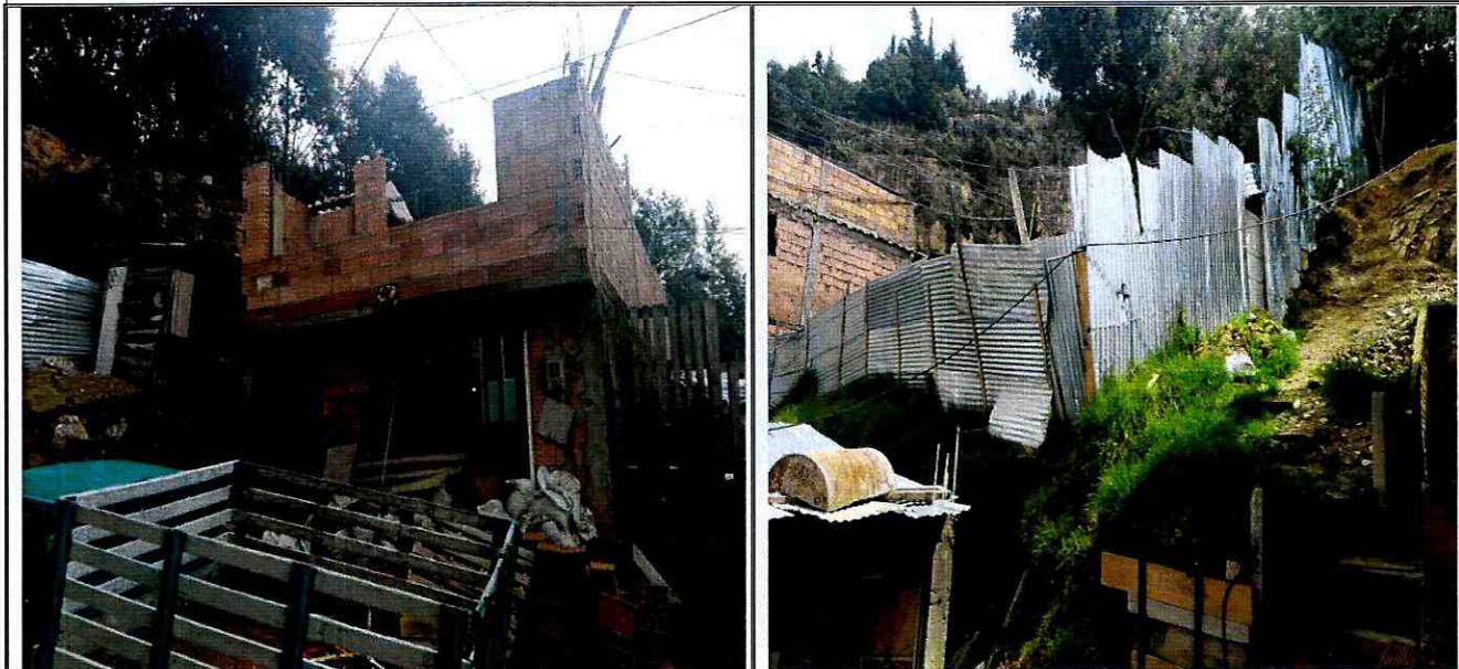
Fotografía 9. Vivienda ubicada en la parte alta de la ladera en el punto con coordenadas de localización Punto 2 X:106505.28 Y:115831.59, sobre la Calle 164 B, expuesta al movimiento en masa valorado.
