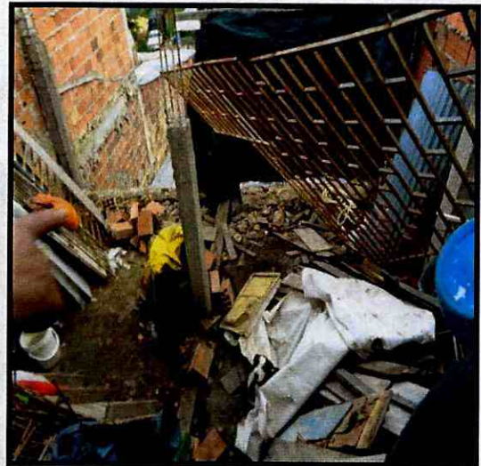
Fotografía 3. Construcción posterior en el predio de la Señora Rodríguez
