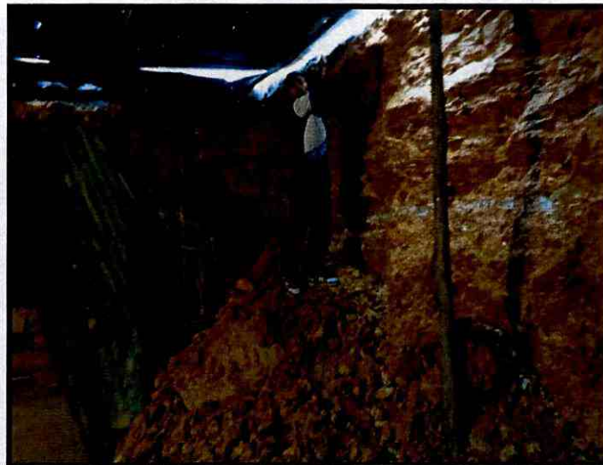
Fotografía 8. Desprendimiento del talud de corte ubicado al costado norte del predio de la señora Fonseca
