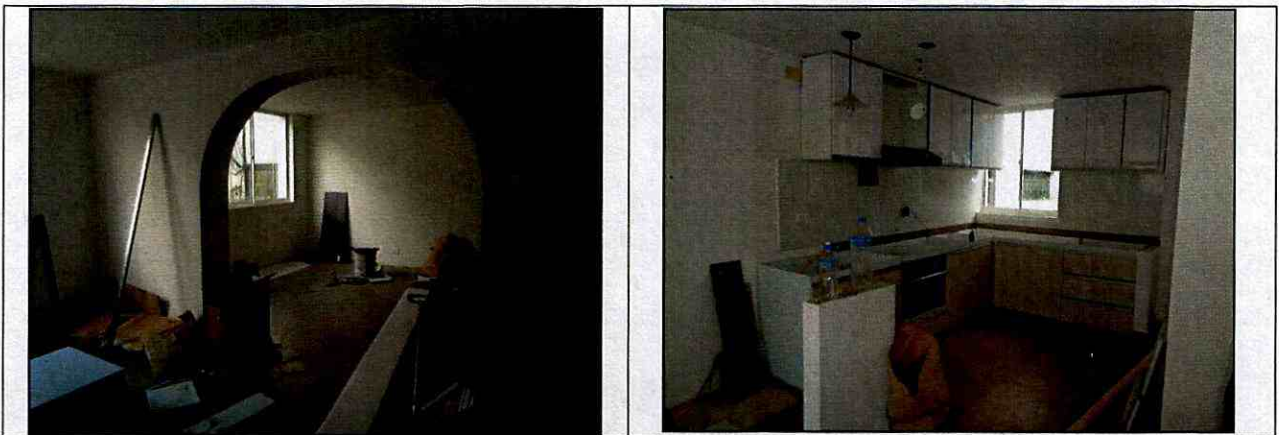
Fotos 5 y 6. Vista de las adecuaciones que se adelantan en el primer nivel del apartamento 301.
