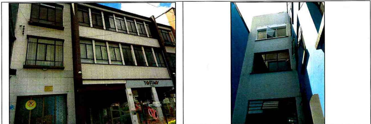
Fotos 1 y 2. Vista del Edificio Uruguay emplazado en el predio de la Carrera 19 No. 39A-47, emplazado en el Sector Catastral La Soledad de Localidad de Teusaquillo.
