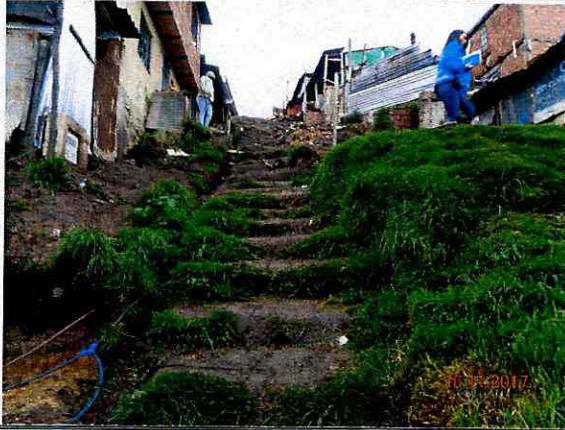
Foto No. 1. Acceso al predio de la Calle 82 C Sur No. 18N-19
