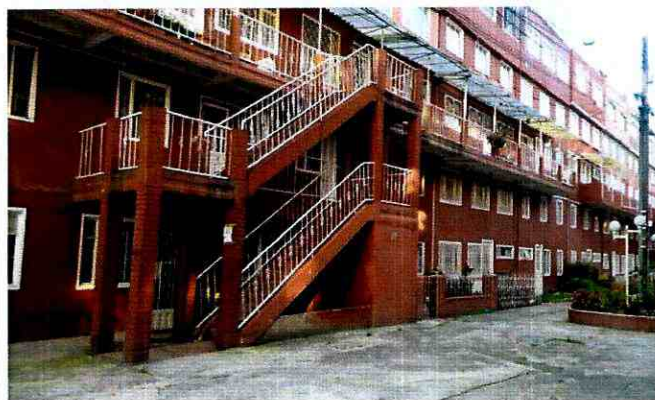
Fotografía 3. Escaleras de acceso a los apartamentos superiores de los bloques de apartamentos ubicados en el predio de la Calle 82 B No. 94 L – 30, en el Sector Catastral Bachue de la Localidad Engativá.
