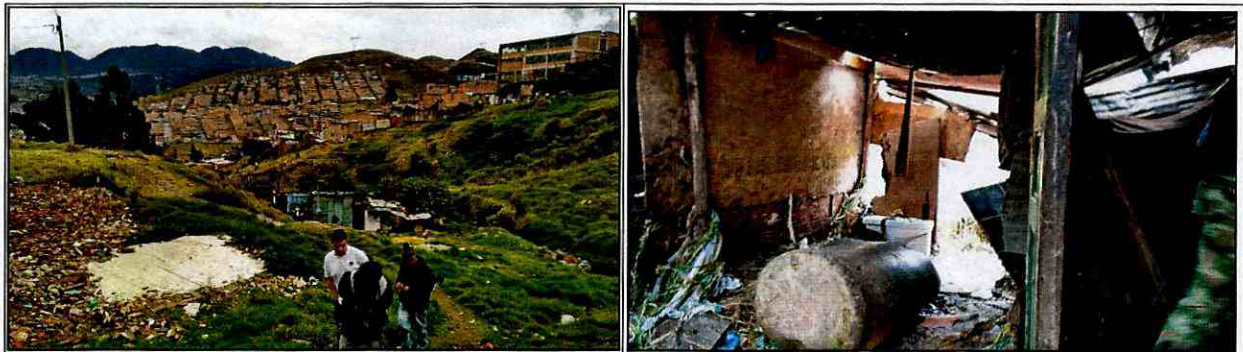
Fotos 1 y 2. Vista de la vivienda evaluada.
