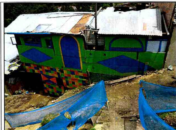
Foto 1. Vista de la vivienda emplazada en el predio de la Calle 11C Sur No. 23-12 Este, en el Desarrollo Laureles Sur Oriental I Sector de la Localidad de San Cristóbal.
