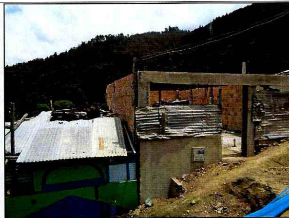
Foto 2. Vista de la construcción que se adelanta en el predio de la Calle 11C Sur No. 23-18 Este, en el Desarrollo Laureles Sur Oriental I Sector de la Localidad de San Cristóbal.
