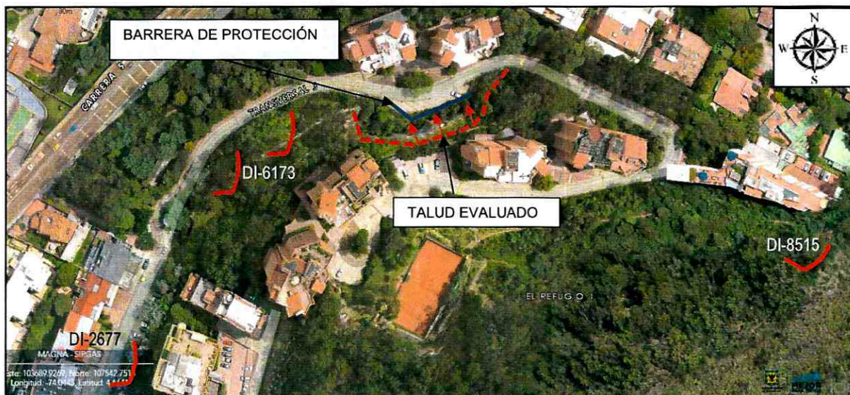
Figura No 1. Ubicación del predio de la Transversal 3 No. 85 – 10, conjunto residencial Altos del Refugio de la Localidad de Chapinero.
