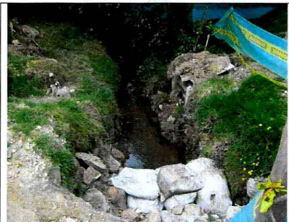
Fotografía 3. Vista de la quebrada limas, aguas arriba del “puente”, se observa limpieza en el sector.
