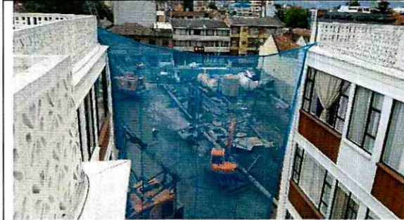
Fotografía 3. Vista al interior del predio con dirección Carrera 19 No. 33 A – 75 desde la terraza, en el Sector Catastral Teusaquillo de la Localidad de Teusaquillo.
