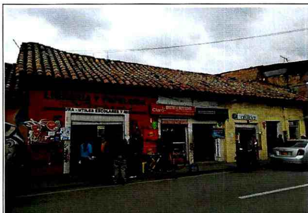
Fotografía 1. Fachada principal de la edificación del predio de la Calle 63 Sur No 80C-25.
