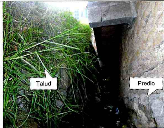
Fotografía 4. Vista en detalle de la cara del talud (zona media), contiguo al predio, no se observan deslizamientos.
