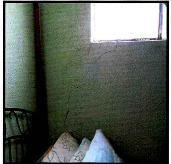
Fotografía 3 y 4. Fisuras en el antepecho de la ventana de la habitación del costado sur occidental del predio de la Calle 79 B No 70D-06
