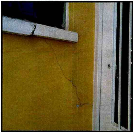
Fotografía 3 y 4. Fisuras en el antepecho de la ventana de la habitación del costado sur occidental del predio de la Calle 79 B No 70D-06
