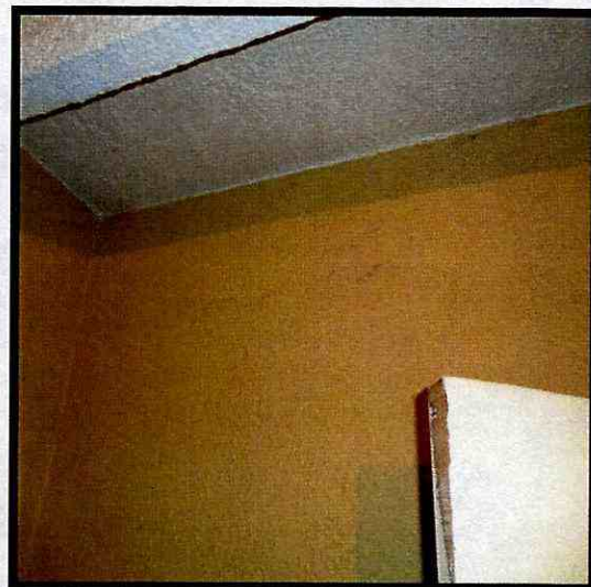
Fotografía 5 y 6. Fisuras en muros divisorios en el predio de la Calle 79 B No 70D-06
