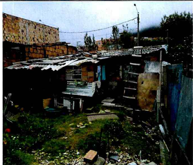
Fotografía 3. Vista de la zona posterior de la vivienda ubicada en el predio de la Carrera 13 C Este No. 75 B – 41 Sur, en el Sector Catastral Juan Rey Sur de la Localidad Usme.
