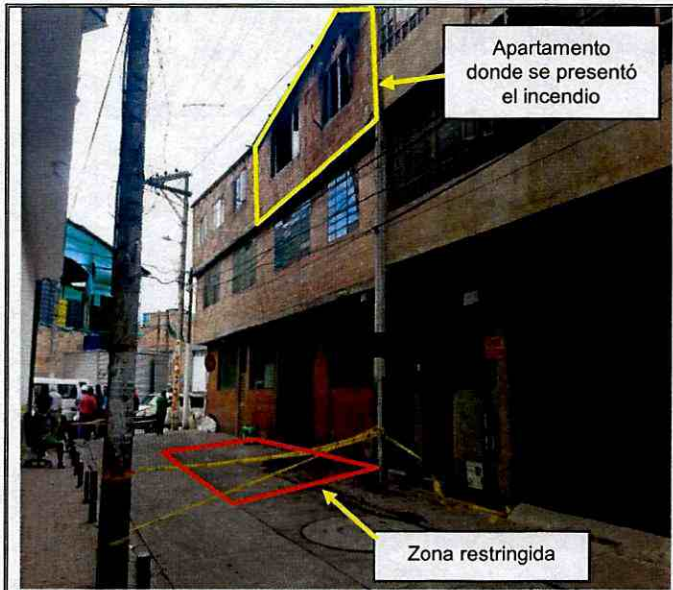
Fotografía 1. Vista de la edificación donde se presentó el incendio en el apartamento norte del tercer nivel del predio de la Diagonal 34 A Sur No. 81 A – 06, en el Sector Catastral Maria Paz de la Localidad Kennedy.
