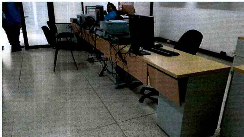
Fotografía 4. Acabados de piso en buen estado
