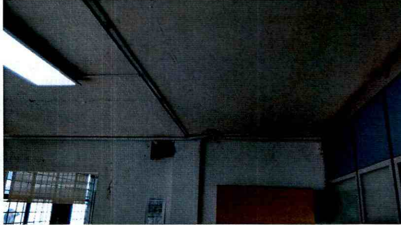
Fotografía 3. Cielo raso sin grietas o fisuras
