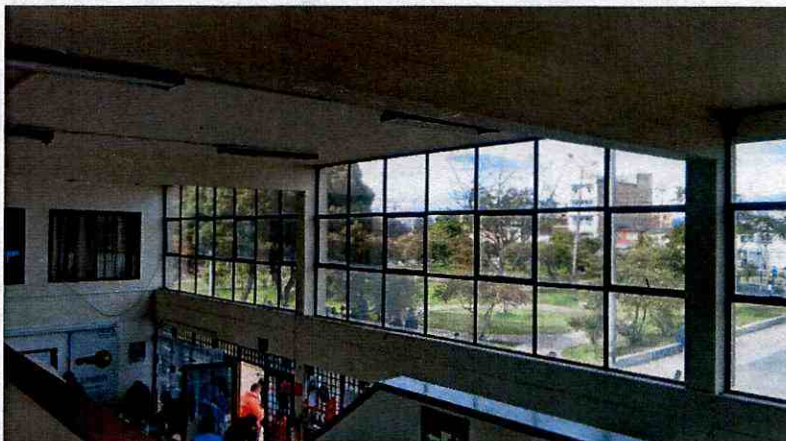
Fotografía 2. Elementos estructurales tipo vigas y columnas en buenas condiciones
