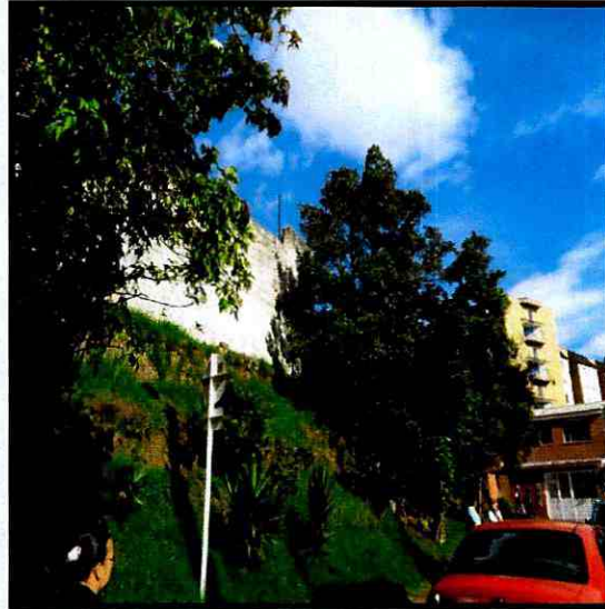
Fotografía 1. Muro que divide el Conjunto Agrupación de vivienda El Diamante y el Cementerio Renacer
