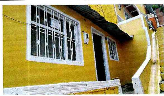
Fotografía 2. Vista de las edificaciones de la Carrera 2 B No. 48 N – 29 Sur y Carrera 2 B No. 48 N - 23 Sur en el Barrio Los Puentes de la Localidad Rafael Uribe Uribe
