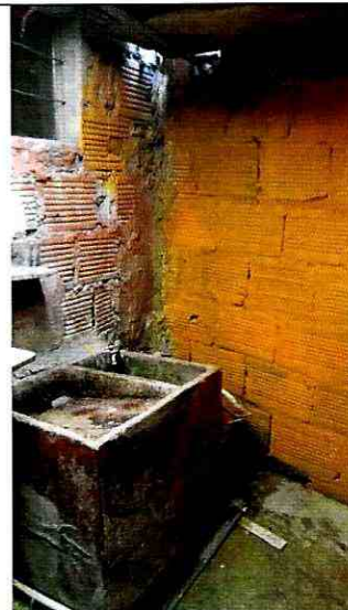
Fotografía 3 y Fotografía 4. Vista al interior de la vivienda del predio de la Carrera 2 B No. 48 N – Sur del Barrio Los Puentes de la Localidad Rafael Uribe Uribe
