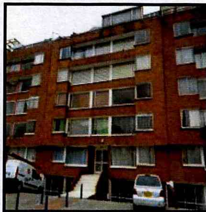
Fotografía 1 .Vista general de la edificación emplazada en el predio de la Calle 26 No 73-36 en la Localidad de Engativá
