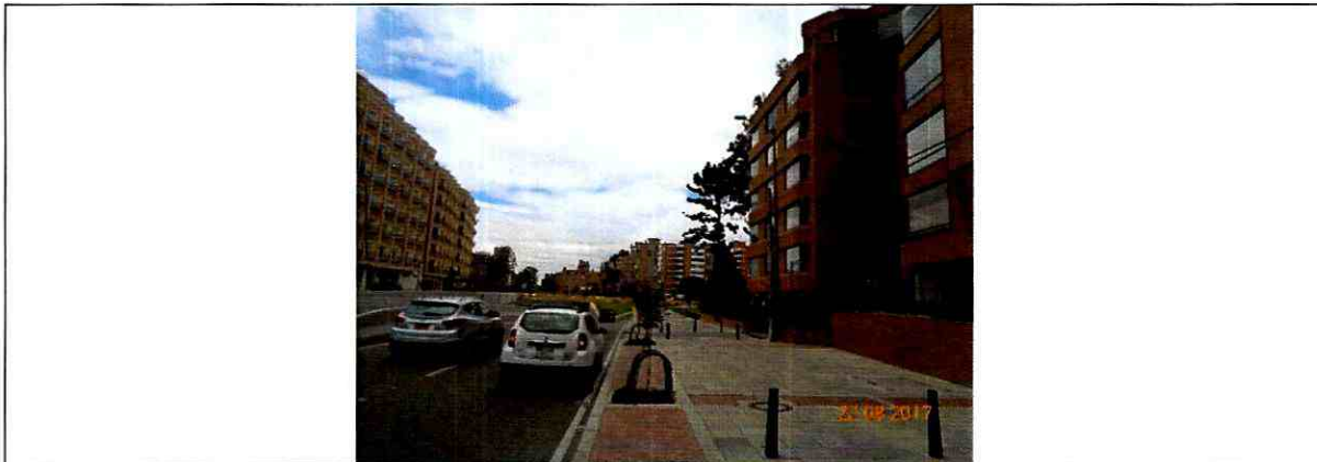
Foto 1: Vista de la fachada del predio de la Calle 94 N° 18-66 de la Localidad de Chapinero.
