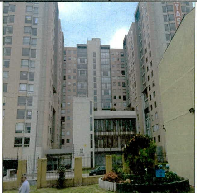
Fotografía 10. Vista de las torres de apartamentos que conforman el conjunto residencial Mirador de Córdoba, ubicado al costado norte de la Agrupación de Vivienda Multifamiliares Prado Veraniego.
