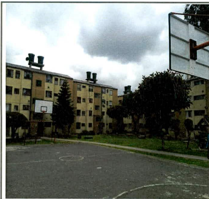
Fotografía 1. Vista de la Agrupación de Vivienda Multifamiliares Prado Veraniego, ubicada en el predio de la Carrera 54 B No. 128 – 39, en el Sector Catastral Prado Veraniego Sur de la Localidad Suba.
