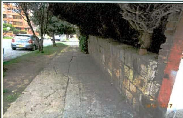
Foto No. 3. Vista costado sur predio de la Carrera 4 A No. 57 - 02
