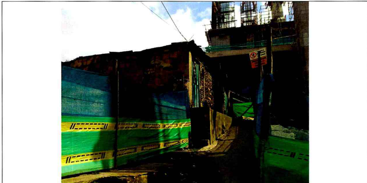
Fotografía 1: Vista de la vivienda emplazada en el predio de la Carrera 18 R N° 66 D - 06 Sur y la obra donde se realiza la adecuación del transmicable en la Localidad de Ciudad Bolívar.
