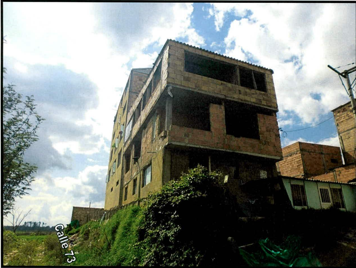
Fotografía 1 .Vivienda localizada en el predio de la Carrera 124 No 73-03
