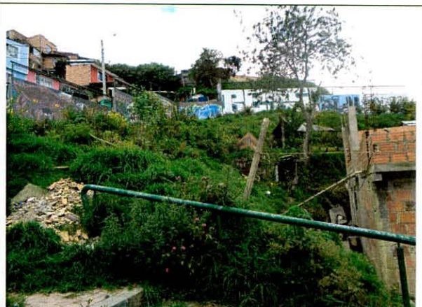
Fotografía 4. Viviendas del costado Norte del campo deportivo del Barrio San Dionisio, que no tienen medidas de protección.
