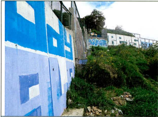
Fotografía 7. Muro perimetral del costado sur del campo deportivo del Barrio San Dionisio.
