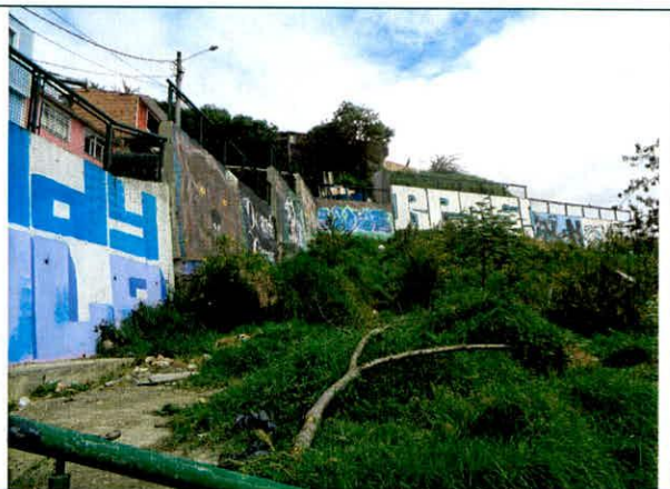
Fotografía 6. Muro perimetral del costado sur del campo deportivo del Barrio San Dionisio.
