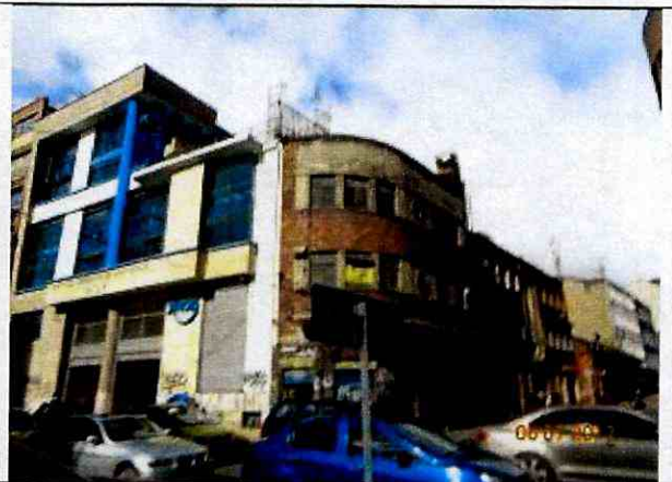
Fotografía 4. Edificaciones en la esquina de la calle 20 con carrera 5.
