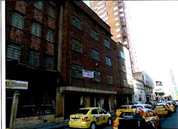
Fotografía 5. Edificaciones en la carrera 5, costado oriental.
