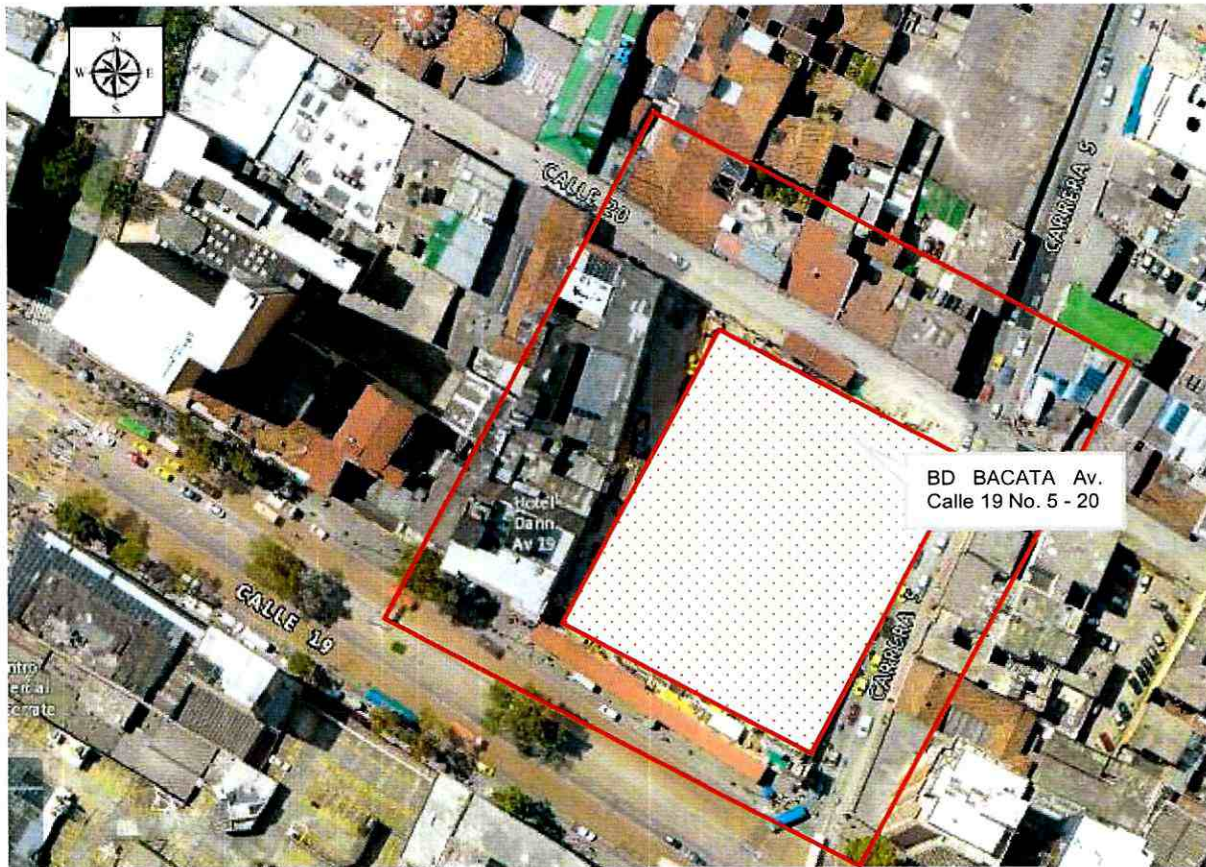
Figura 1. Localización de Edificio BD BACATÁ (Av. Calle 19 No. 5 – 20) y sector de influencia.
