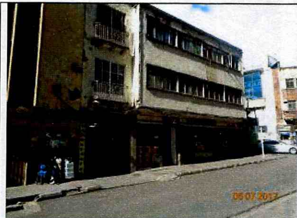
Fotografía 3. Edificaciones en la esquina norte de la calle 20
