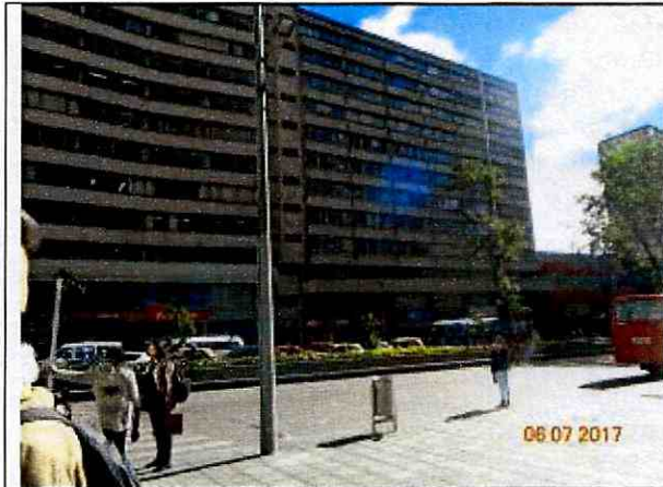
Fotografía 9. Avenida Calle 19 costado norte, frente al edificio BD Bacatá.
