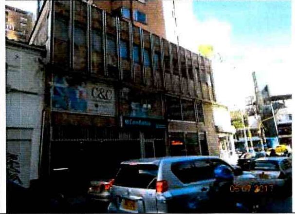
Fotografía 6. Edificación de la esquina de la carrera 5 con calle 19, costado oriental.
