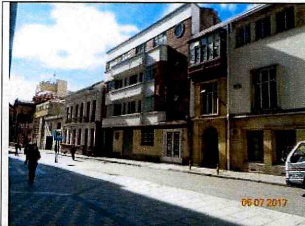
Fotografía 1. Vista panorámica de las edificaciones de la calle 20 entre carreras 5 y 7.
