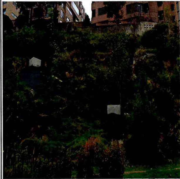
Foto No. 4. Cajas de inspección en la parte media del talud
