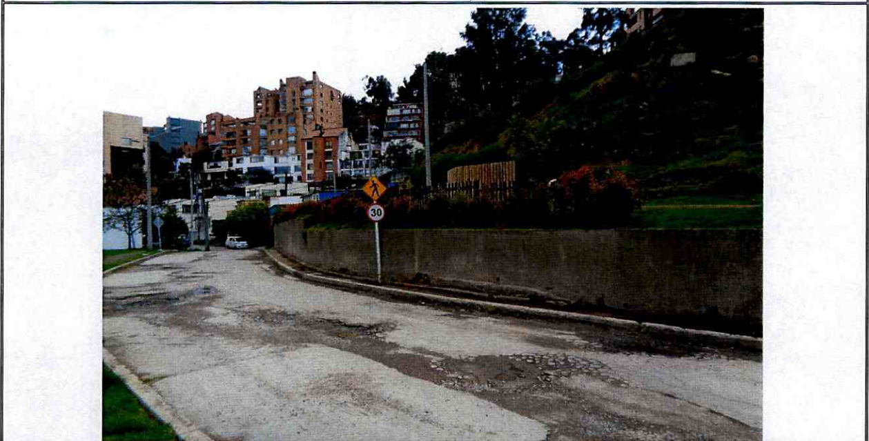
Foto No. 2. Muro de contención en mampostería ubicado en la parte baja del talud ubicado en el predio de la Calle 55 No. 1 A – 40, Sector Catastral Ingemar de la Localidad de Chapinero
