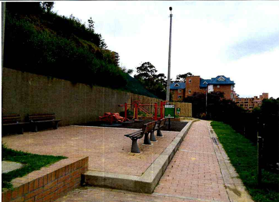
Foto No. 5. Zona de recreación y muro de contención ubicado en la parte media del predio de la Calle 55 No. 1 A - 40, Sector Catastral Ingemar de la Localidad de Chapinero
