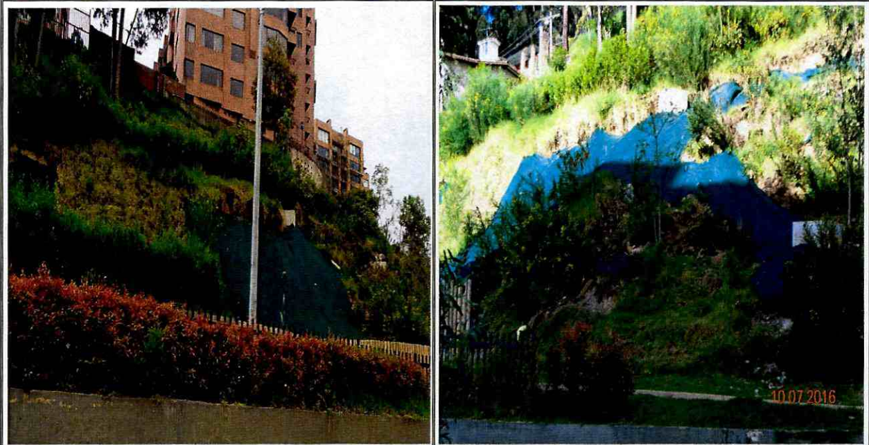
Foto No. 6 y 7. Manto contra erosión instalado en la parte media del talud del predio de la Calle 55 No. 1 A – 40, Sector Catastral Ingemar de la Localidad de Chapinero
