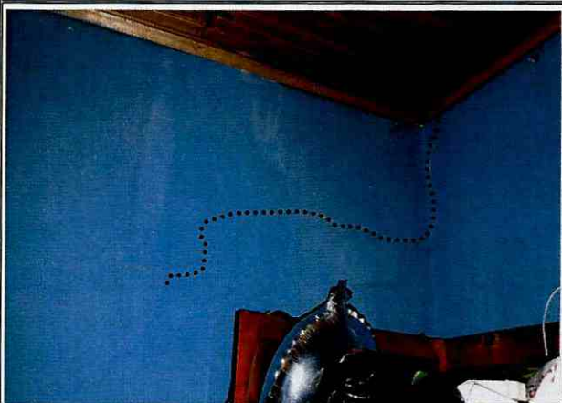
Foto No. 5 y 6. Daños en muros perimetrales en la vivienda emplazada en el predio de la Carrera 92 No. 72 - 95
