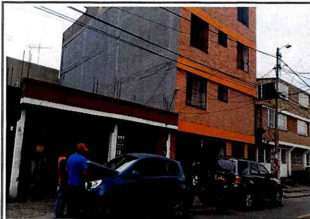
Foto No. 1. Vista frontal de los predios de la Carrera 92 No. 75 - 95 / 99
