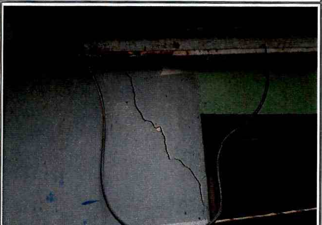
Foto No. 5 y 6. Daños en muros perimetrales en la vivienda emplazada en el predio de la Carrera 92 No. 72 - 95
