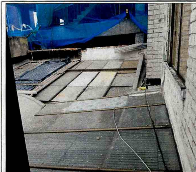
Fotografía 9. Cubierta de la zona posterior del primer nivel de la edificación ubicada en el predio de la Calle 76 No. 15 – 17, en el Sector Catastral Porciúncula de la Localidad Chapinero.
