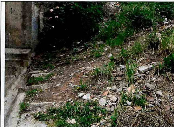
Fotografía 7. Canales de conducción de aguas lluvias sobre la carrera 12 l.
