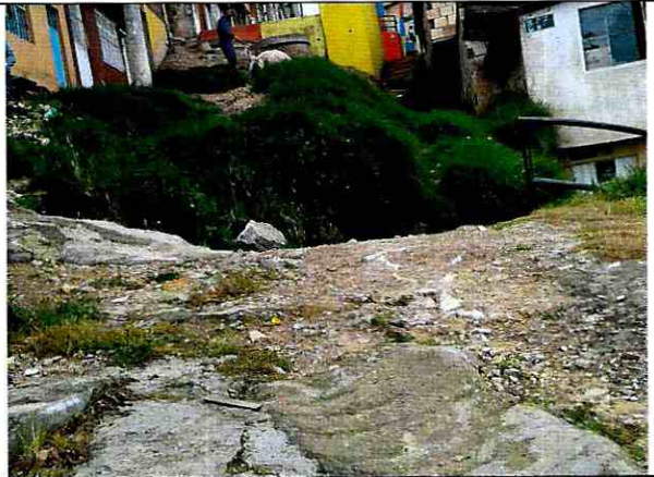
Fotografía 2. Parte media del sector evaluado, a la altura de la Carrera 12 I con la de la calle 32 D Bis Sur.
