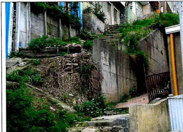
Fotografía 1. Muro de contención que se encuentra en la parte alta del sector evaluado.
