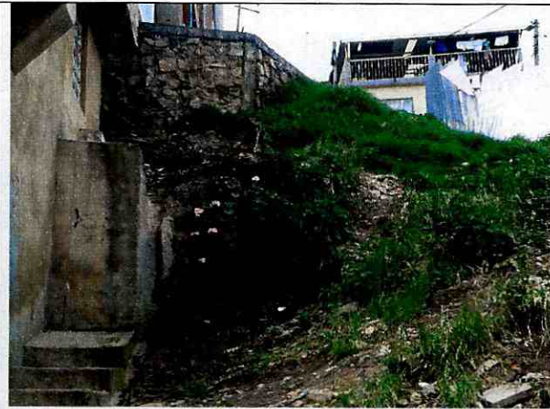
Fotografía 6. Muro de contención en piedra pegada Sobre la Carrera 12 l entre la Diagonal 32D Bis A y la Diagonal 32F Sur. Fotografía de Junio de 2017
