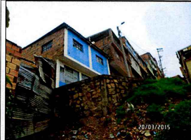
Fotografía 5. Muro de contención en piedra pegada Fotografía tomada del DI-8101 de marzo de 2015
