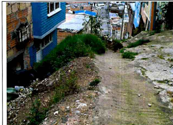
Fotografía 3. Sendero peatonal conformado por una huella en mortero de la parte media del sector evaluado.
