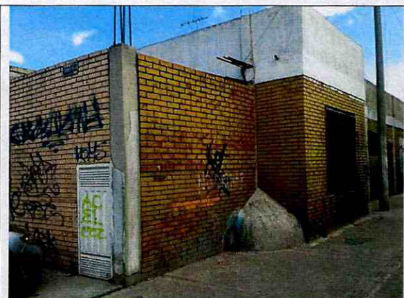
Fotografía 3. Estructura conformada por mampostería confinada mediante columnas.
