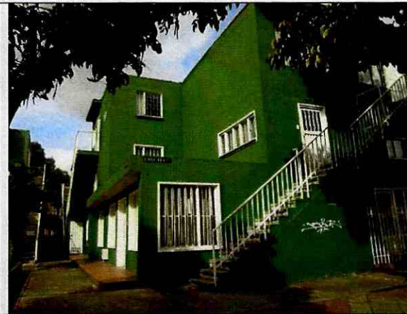
Fotografía 8. Vista del costado noroccidental del bloque 29.
