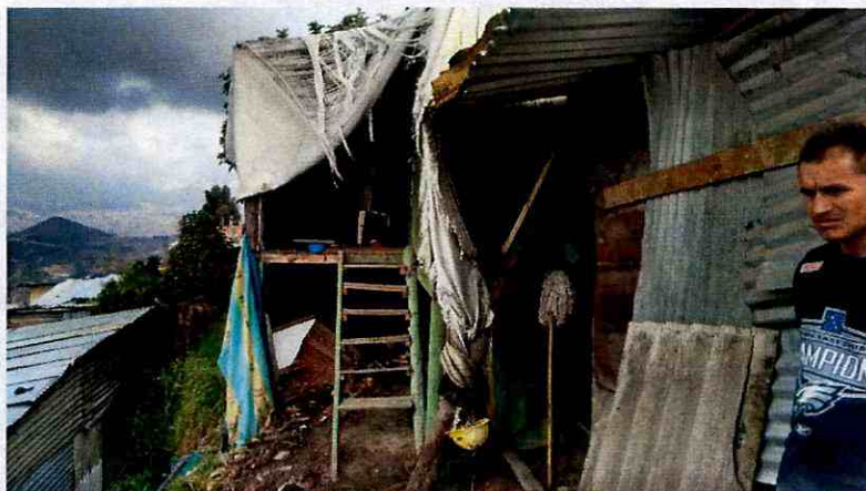
Fotografía 3. Configuración de la edificación ubicada en el predio de la Calle 71A Sur # 22 – 09 (Predio 2, figura1)
