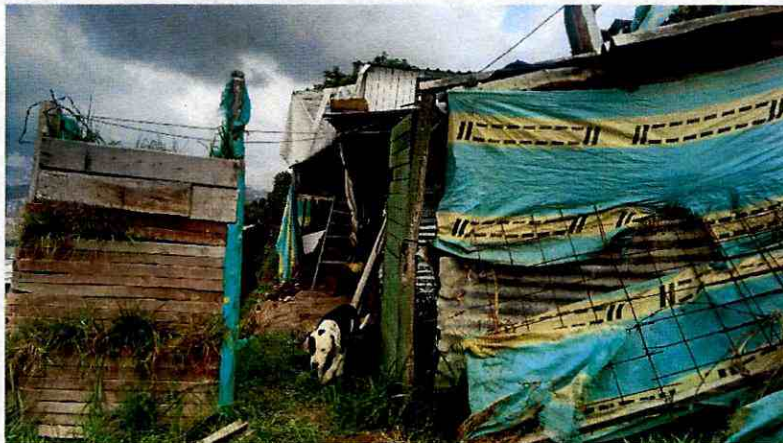
Fotografía 1. Vista general del inmueble ubicado en la Calle 71A Sur # 22 – 09 (Predio 2, figura1).
