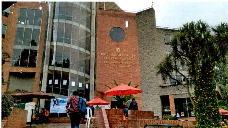
Fotografía 1. Vista general del inmueble ubicado en la Carrera 5 Este # 15 - 82.
