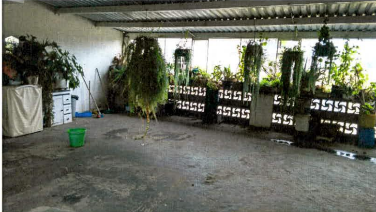
Fotografía 5. Placa de terraza en buenas condiciones. Predio de la Calle 133A # 100 – 03.
