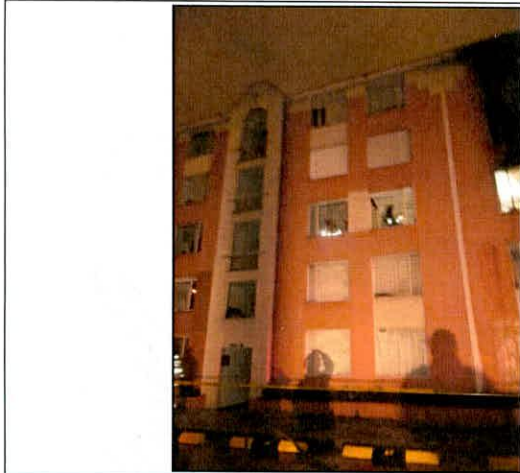
Foto 5. Vista de la Torre 5, localizada al interior del Conjunto Residencial Santa Helena de Baviera III..
