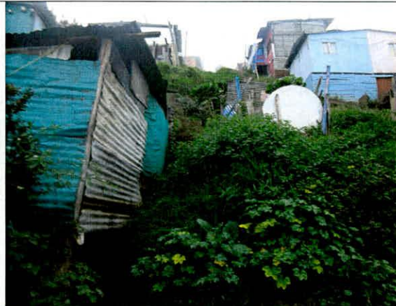
Fotografía 3. Vista de vía a la altura de la Carrera 21 y 22 en el sector evaluado entre los Barrios Los Alpes y Villas del Progreso. Se observa falta de colectores.
