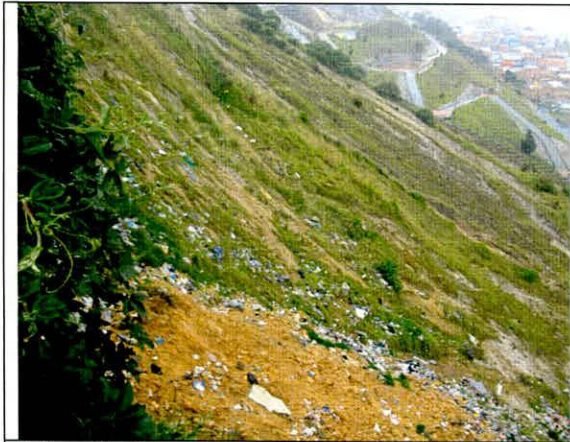
Fotografía 6. Vista del sector correspondiente a antiguo frente de explotación (cantera).
