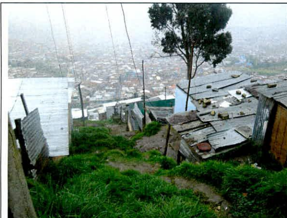
Fotografía 4. Vista de vía ubicada de la parte baja del Barrios los Alpes (costado occidental del sector evaluado). Se observa falta de colectores.
