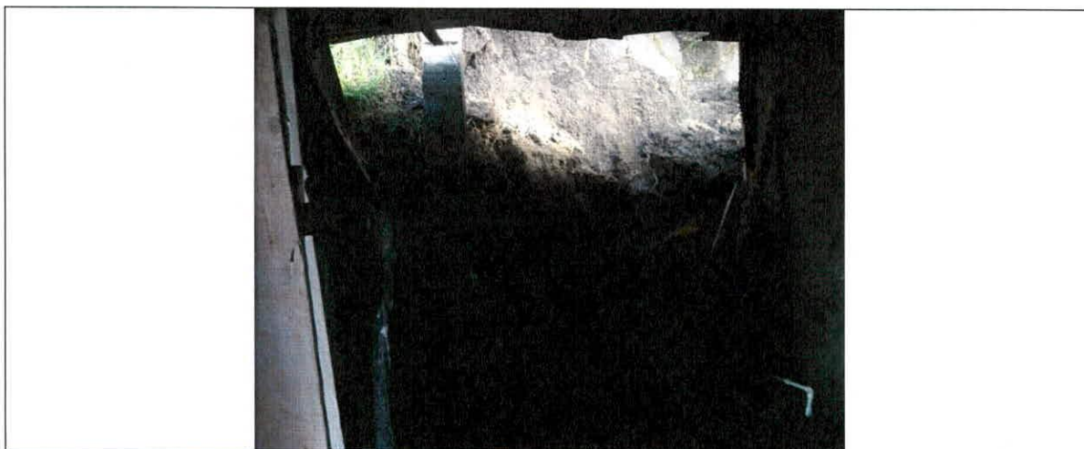
Fotografía 2: Se observa el desprendimiento de material en el talud de corte de la vivienda de la Carrera 73 N # 69 F – 83 Sur, de la localidad de Ciudad Bolívar
