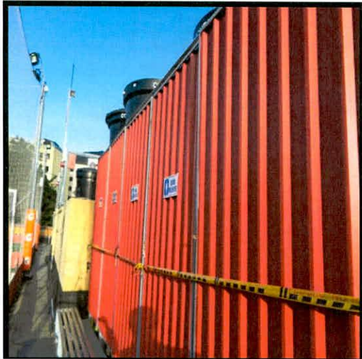
Fotografía 7. Baños metálicos en la terraza sur del Centro Comercial Los Héroes
