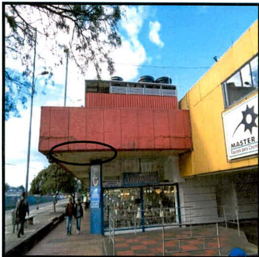
Fotografías 9 y 10. Fisuras en las plaquetas prefabricadas que bordean la placa de la terraza
