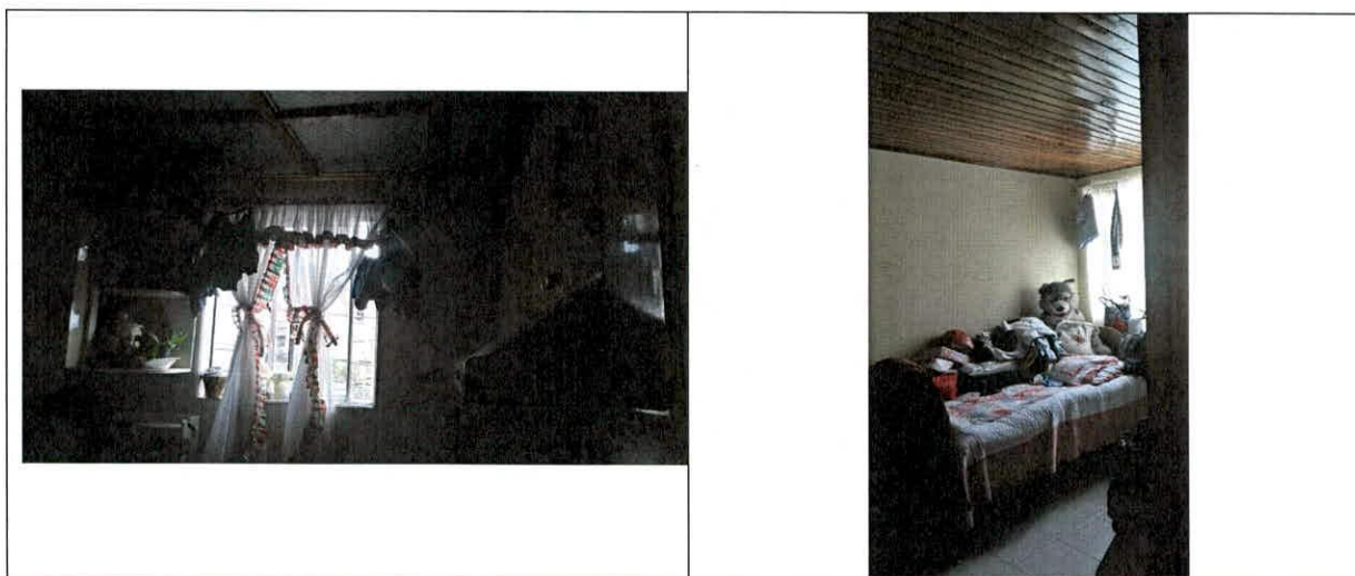
Fotografías 3 y 4. Vista al interior de la vivienda en la que no se aprecian patologías que comprometan la estabilidad y habitabilidad del Apartamento 301.
