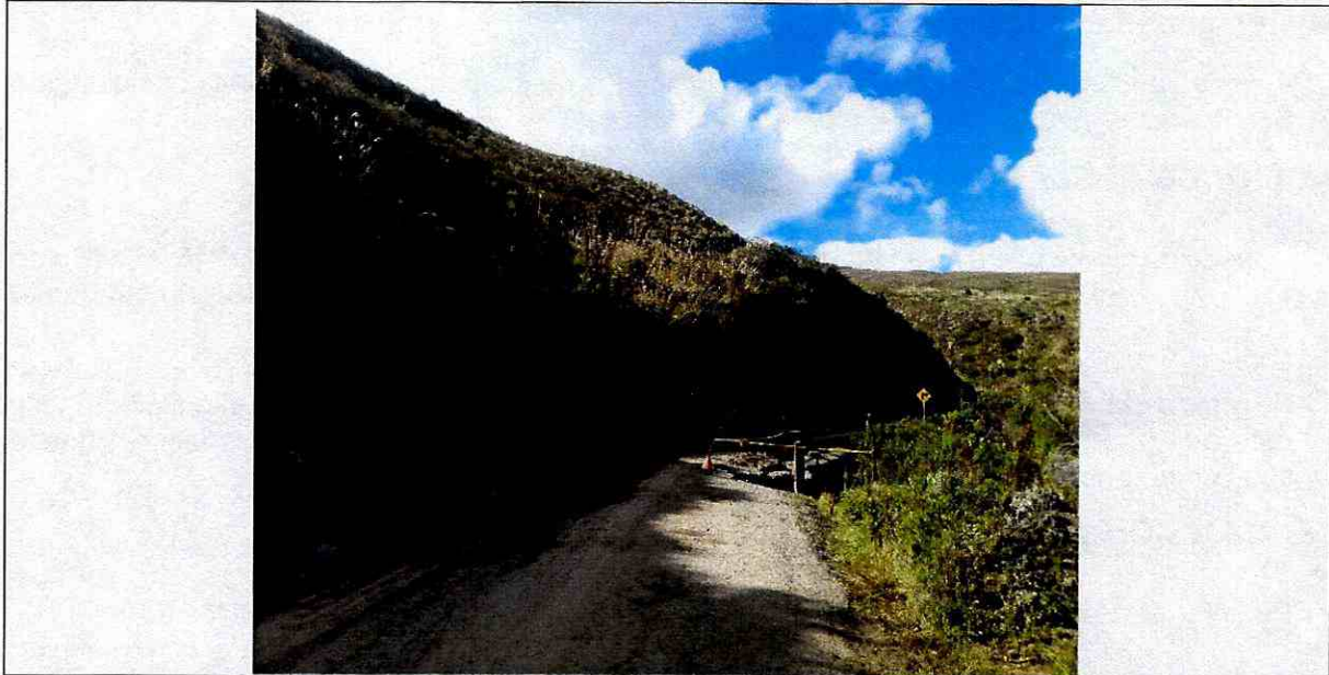
Fotografía 5: Vista del proceso de remoción en masa identificado sobre la vía que conduce a la Vereda Chorreras
