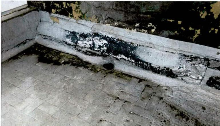
*Fotografía 7. Tubería de desagüe del costado oriental de la placa de terraza en mal estado.*
