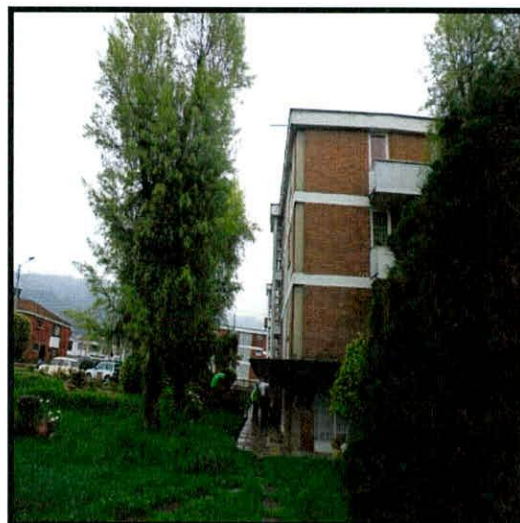
Fotografía 2. Inclinación de la Torre 1 evidenciada el 22 de Mayo de 2017 Página 4 de 8
