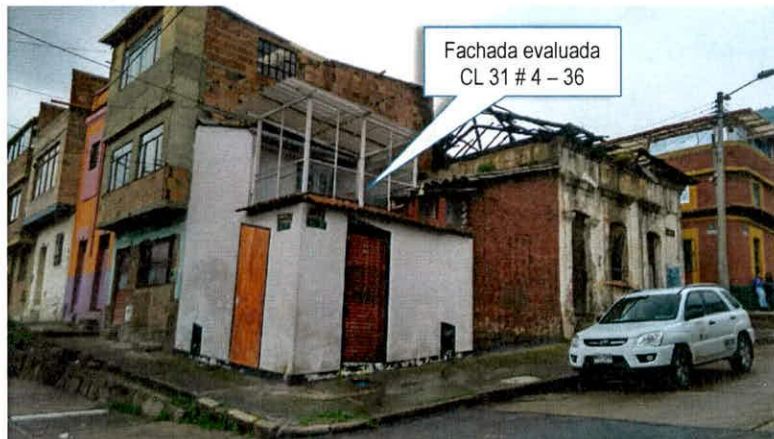
Fotografía 1. Vista general del inmueble ubicado en la Calle 31 # 4 – 36.
