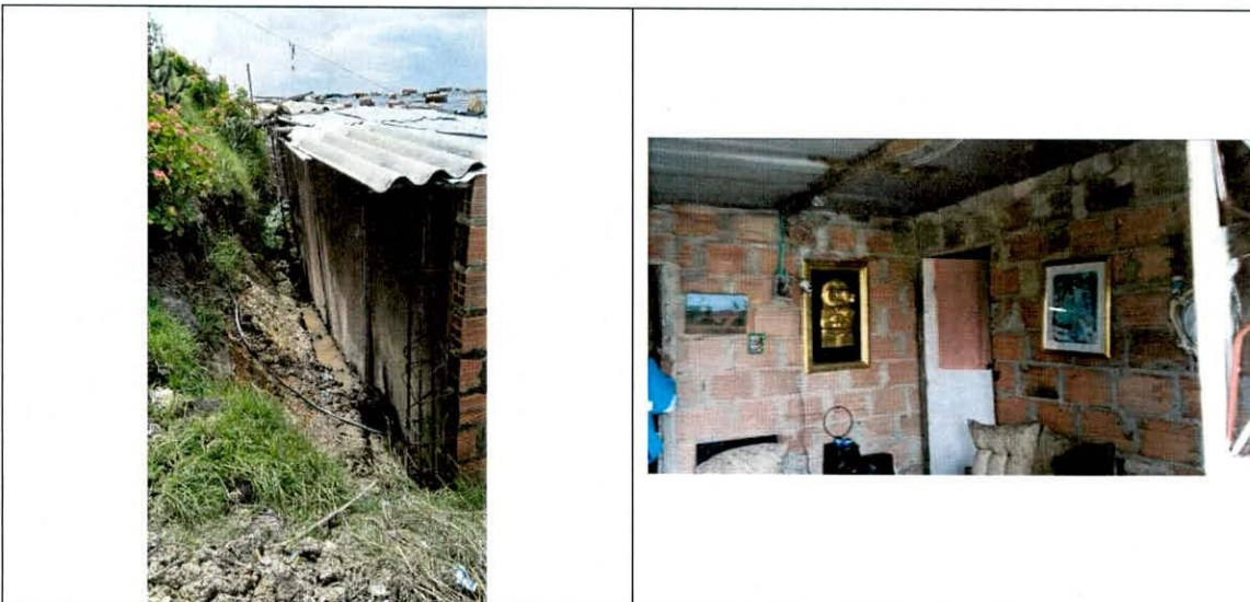
Fotografía 3. Vista del talud de corte ejecutado para emplazamiento de la vivienda.
