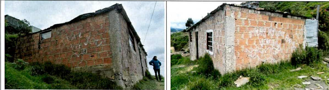
Fotografía 1 y Fotografía 2. Vista general de la vivienda ubicada en el predio de la Calle 81 A Sur No. 19-58
