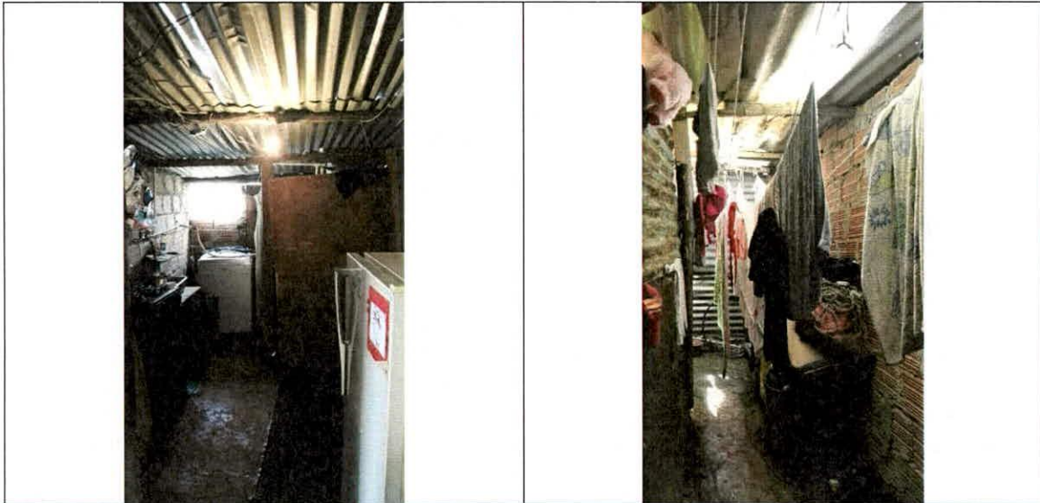
Fotografía 5 y Fotografía 6. Vista de las condiciones actuales de la vivienda. No se identifican patologías estructurales importantes.
